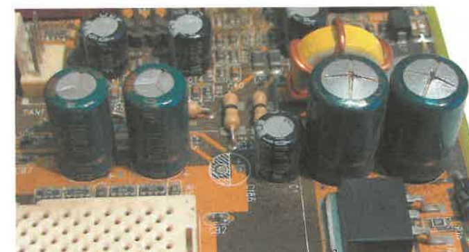
Rys. 102.2. Przykład dobrych kondensatorów (po lewej) oraz napuchniętych (po prawej)
