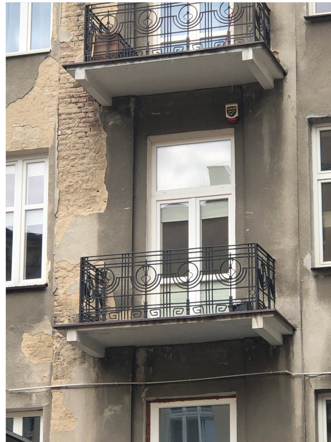
ul. Sądowa- styl art deco , poręcz balkonowa
