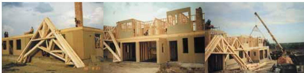
Montaż domu w systemie prefabrykacji otwartej
