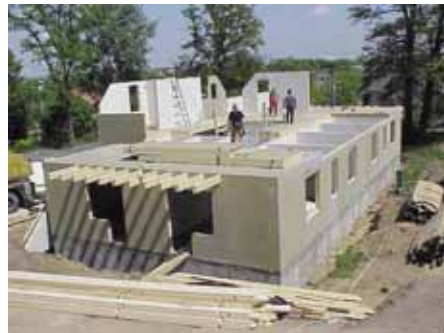
Montaż domu w systemie prefabrykacji zamkniętej
