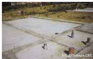
Płyta fundamentowa pod dom drewniany
