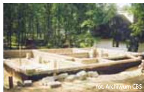
Ściany fundamentowe pod strop z pustką podpodłogową
