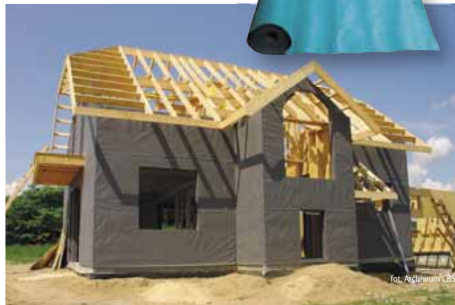
Budynek pokryty wiatroizolacją
