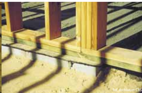
Podwalina impregnowana ciśnieniowo
