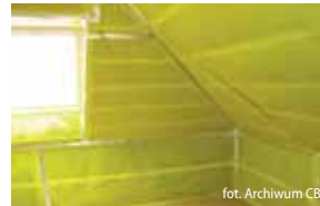
Ściany i dach pokryte folią paroizolacyjną
