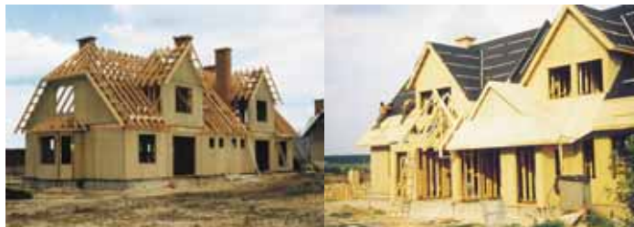
Montaż domu w systemie prefabrykacji otwartej
