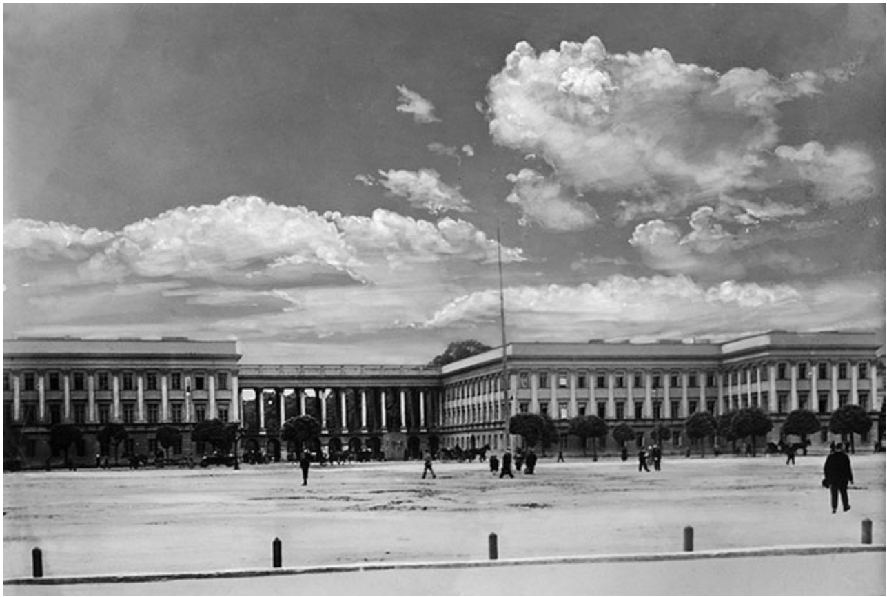
Pałac Saski w Warszawie – siedziba centrali wywiadu wojskowego, w której przetwarzano najważniejsze informacje wywiadowcze.
