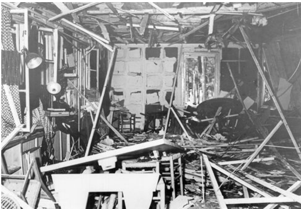
Zniszczona sala konferencyjna (archiwum autora).
