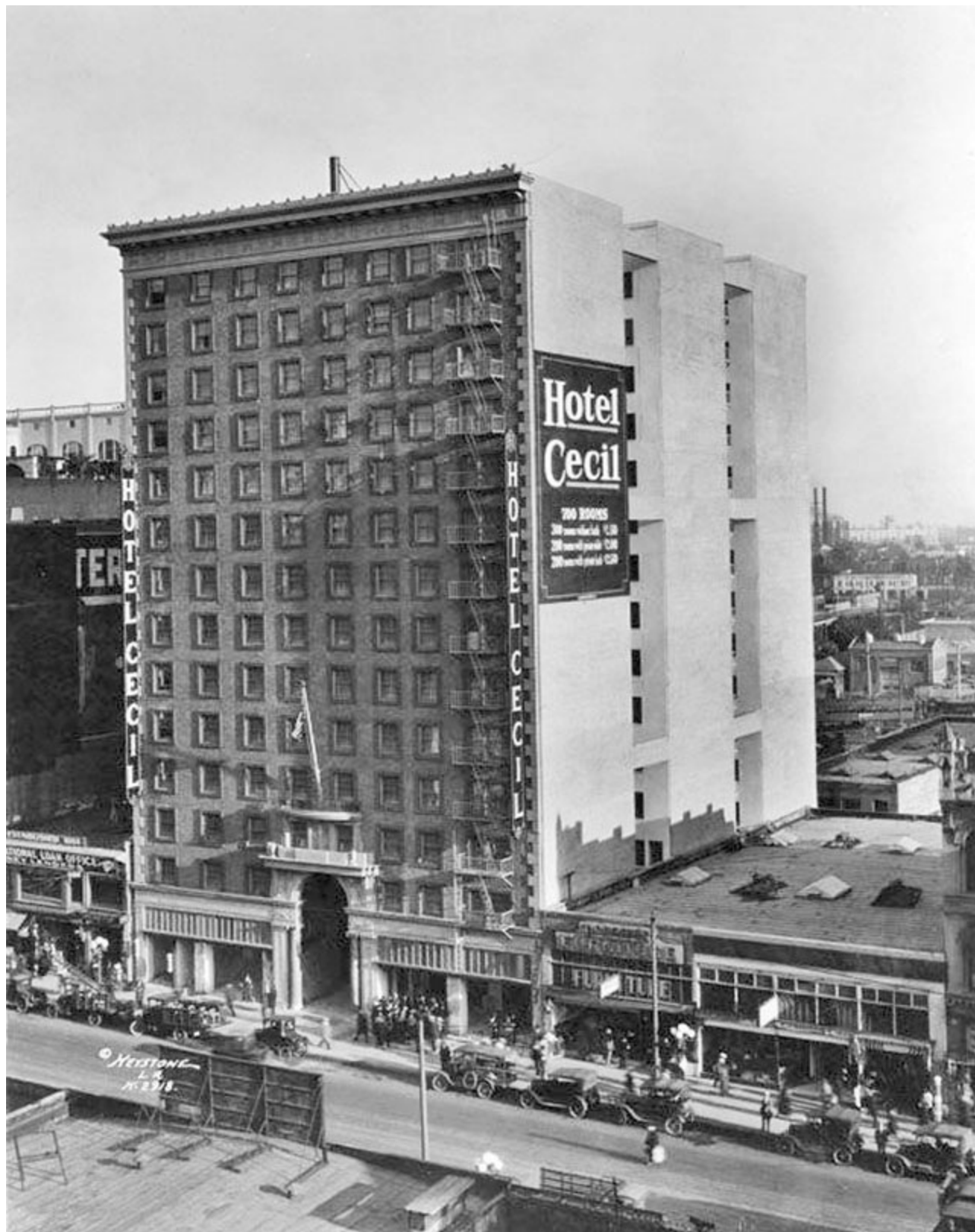
Hotel Cecil niedługo po wybudowaniu
