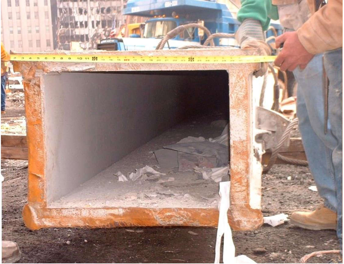
Kolumna ze ściany zewnętrznej (fasady) którejś z wież WTC, badana po katastrofie na terenie „Ground Zero”.
