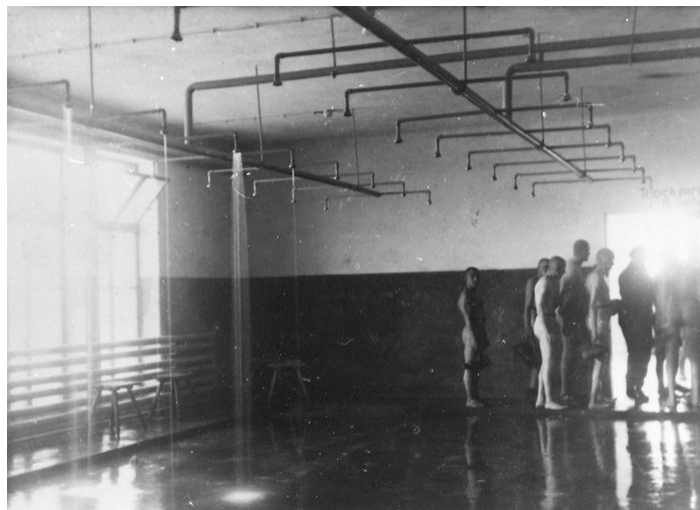
Prysznice w budynku Sauny w Birkenau
