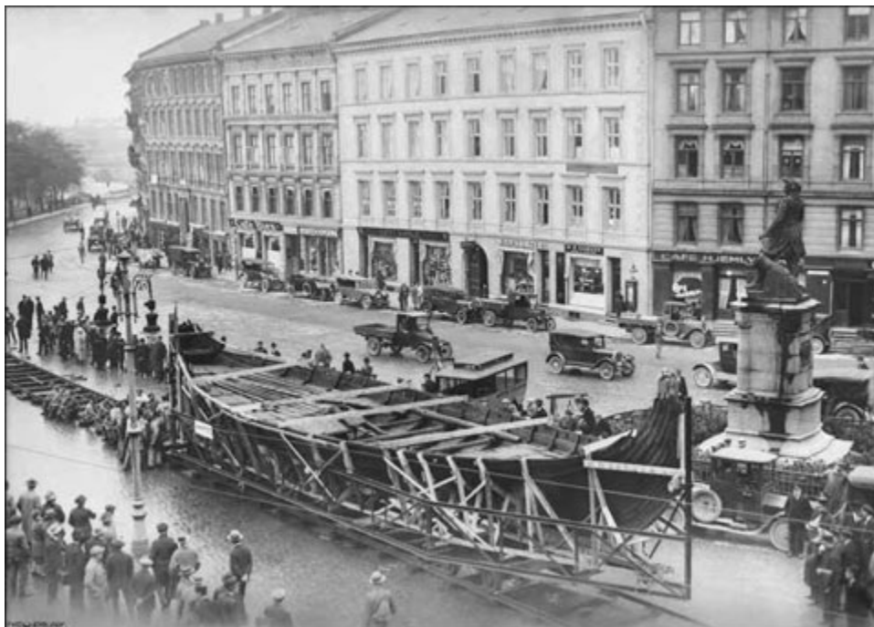
2. W 1926 roku zrekonstruowaną łódź przetransportowano po szynach ulicami Oslo, a następnie promem do specjalnie w tym celu zbudowanego muzeum na półwyspie Bygdøy
