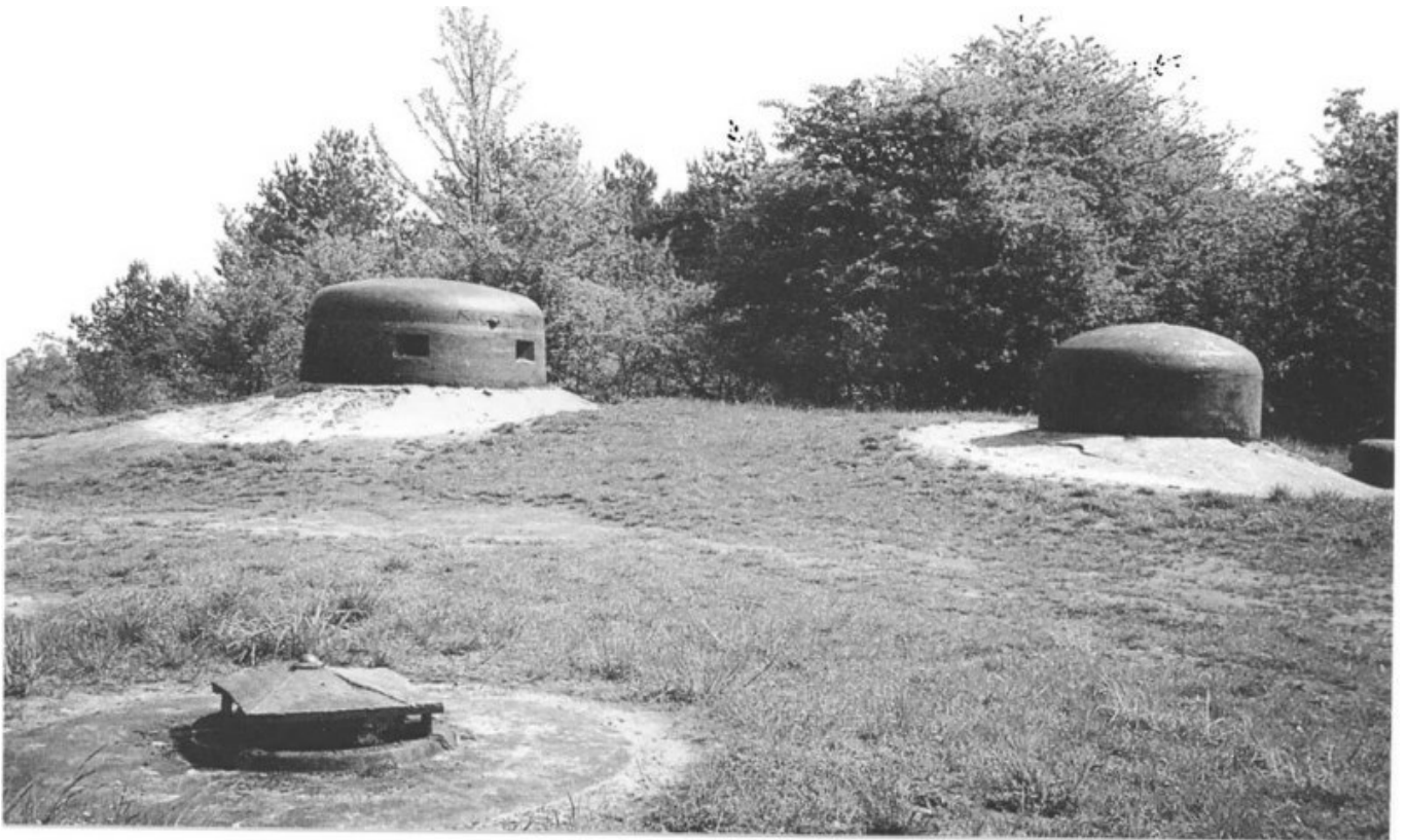
Stalowe kopuły pancernwerku (schronu bojowego) numer 724, grupy warownej „York”, na centralnym odcinku Ufortyfikowanego Frontu Łuku Odry-Warty, zwanego dziś Międzyrzeckim Rejonem Umocnionym.
