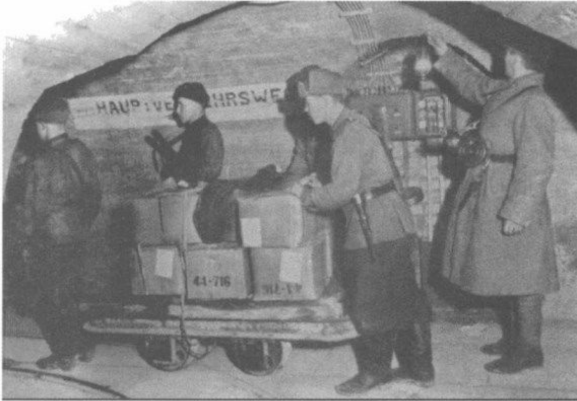
Rosjanie wywożą przeróżne dobra z podziemi fortyfikacji międzyrzeckich. Zdjęcie z archiwum Pawła Piętkiewicza
