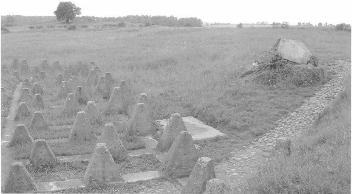
Tak zwane zęby smoka, czyli przeszkody przeciwczołgowe, w miejscu, gdzie czerwonarmiści w końcu stycznia 1945 roku przełamali Ufortyfikowany Front łuku Odry-Warty.
