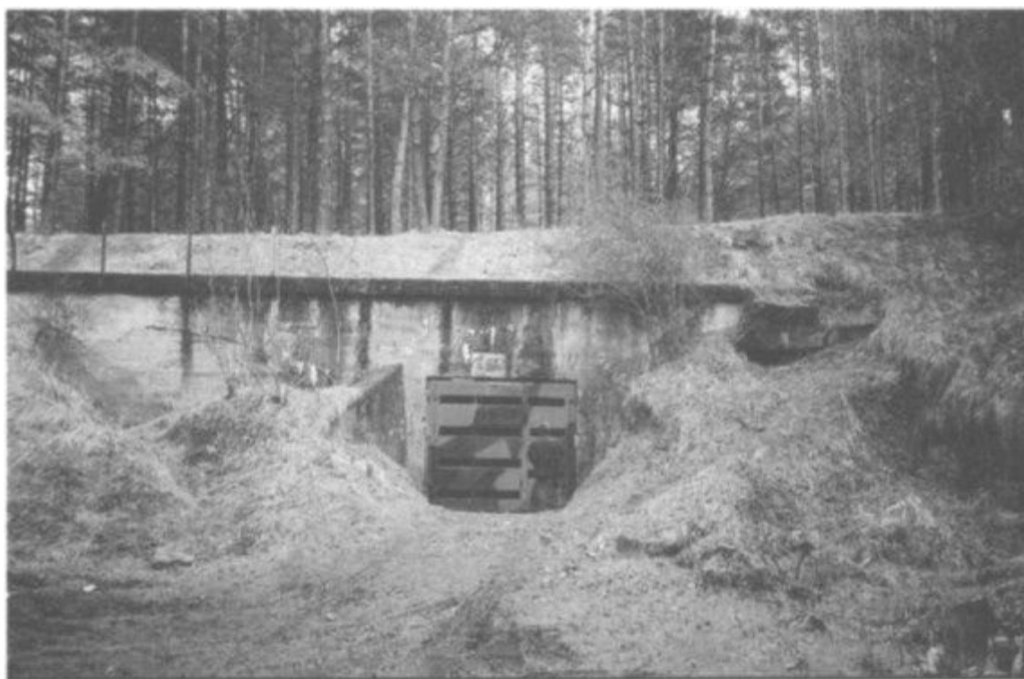
Dawny wjazd A64 do systemu podziemnego MRU. Tą drogą przewożono skarby kultury w wagonikach kolejki wąskotorowej do baterii pancernej numer 5.
