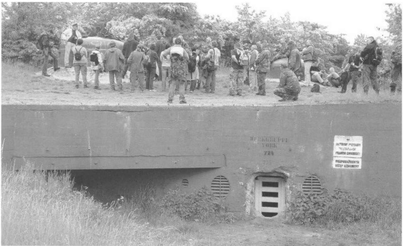
Ten sam pancernwerk 724. i grupa turystów przed zejściem do systemu podziemnego MRU.
