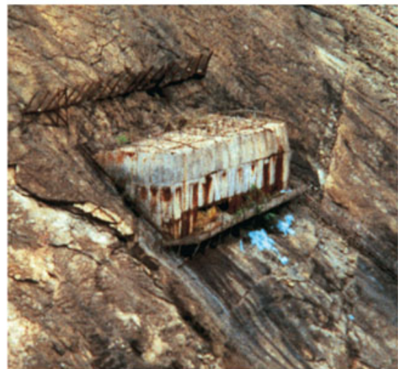
3. Ten reaktor obudowano ochronnym płaszczem z betonu.
