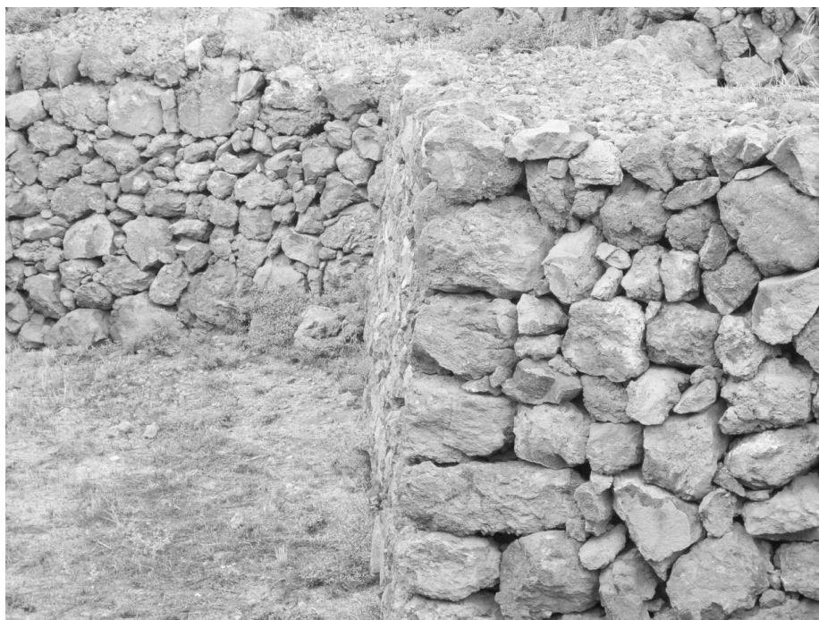
Perfekcyjnie ułożony mur kamienny (fot. Grondkowski).
