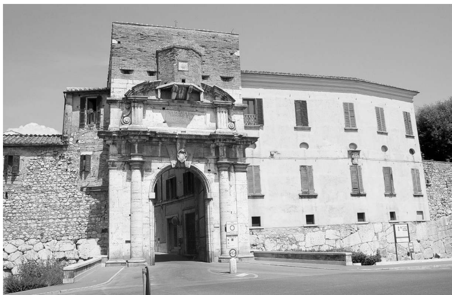
Porta Romana w strefie południowej. Po obu stronach wyraźnie widać odcinki muru poligonalnego, który według tabliczki informacyjnej miał rzekomo powstać między VI i V wiekiem p.n.e. (fot. Broussard).
