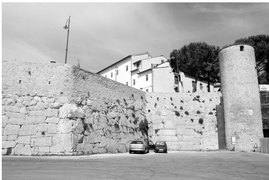
Zdjęcie górne i dolne: wyjątkowe odcinki murów po lewej stronie Porta Romana ilustrują ciągłą zmianę kierunku (fot. Broussard).
