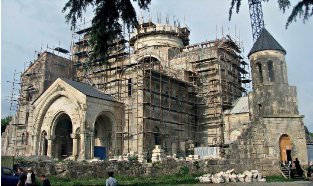
Bagrati w trakcie remontu. Jeszcze pod patronatem UNESCO.
