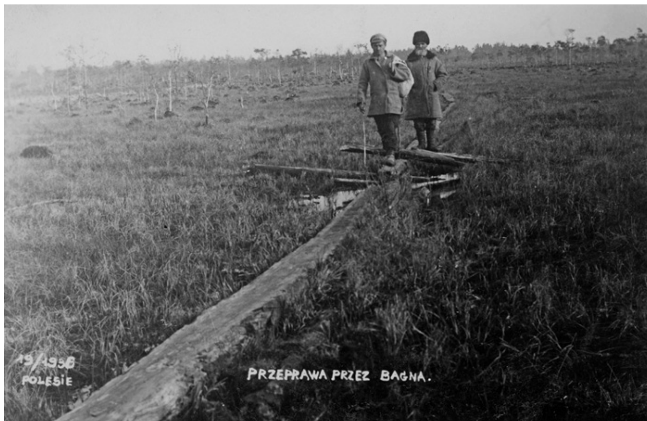
4. Kładki służące do przeprawy przez bagna na Polesiu, 1936, fot. Saul Hochman
