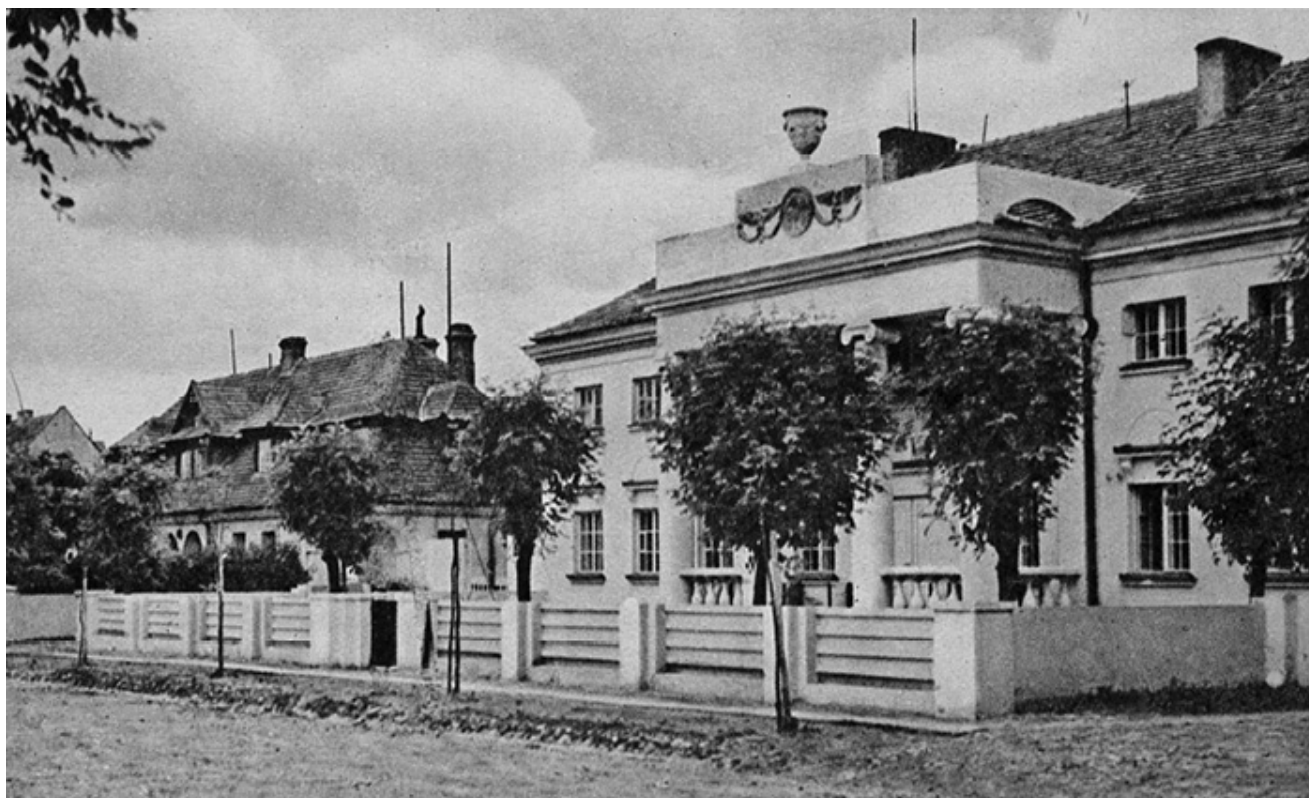
10. Kasyno przy ulicy Pułaskiego, Brześć, 1938
