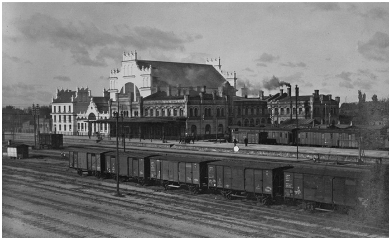
7. Dworzec kolejowy, Brześć, ok. 1929, fot. Jan Wołyński
