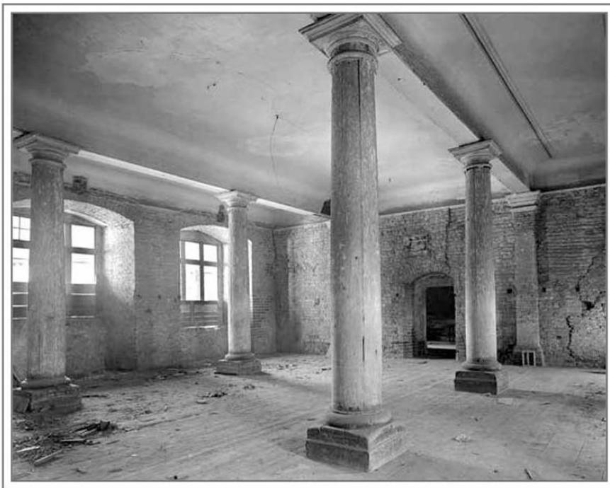
Tak zwana sala Kolumnowa (dawna izba stołowa króla na pierwszym piętrze) na początku XX wieku. Drewniane kolumny ustawiono w niej nie dla ozdoby, ale w celu podparcia stropu grożącego zawaleniem.
