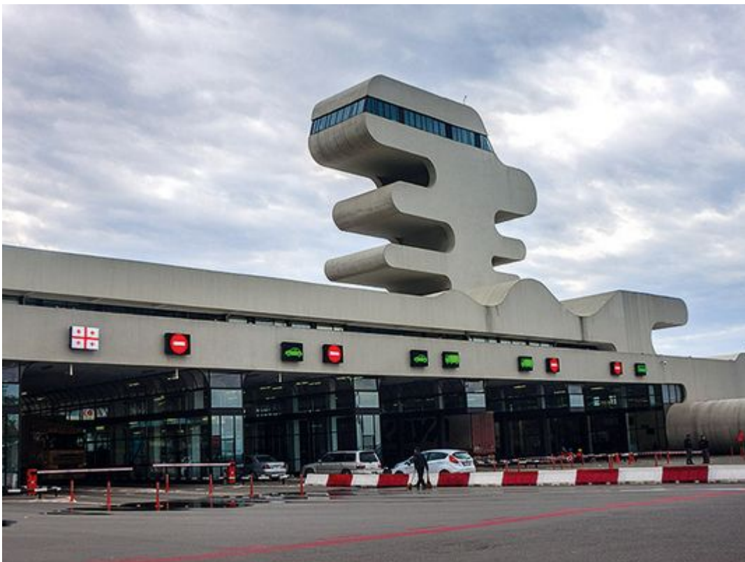
Przejście graniczne w Sarpi
