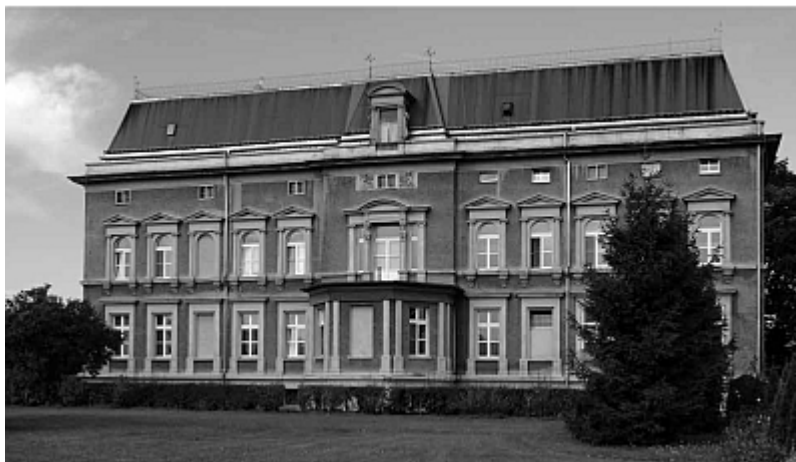
Pałac w Pogrzebieniu od strony ogrodu
