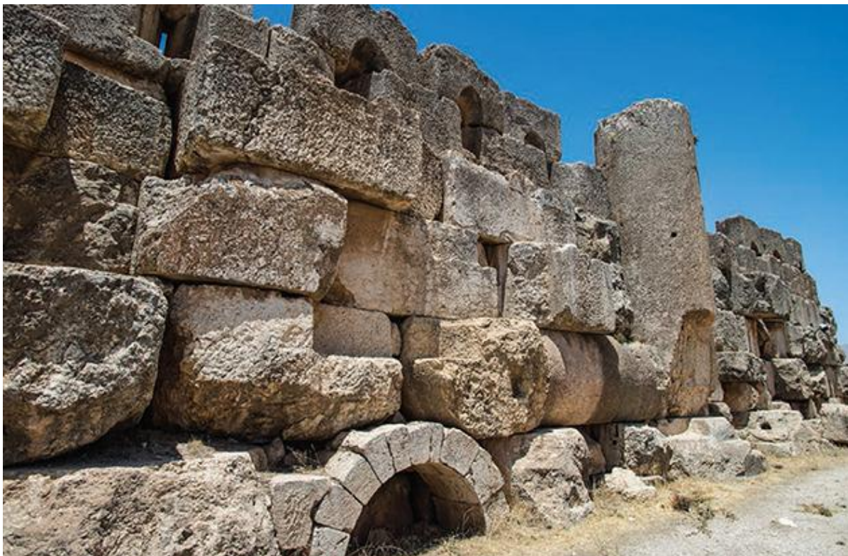
42. Mur fortyfikacji zbudowanych w Baalbek przez Arabów z użyciem starszych rzymskich bloków. Na prawo od łuku widać ułożony poziomo bęben kolumny.
