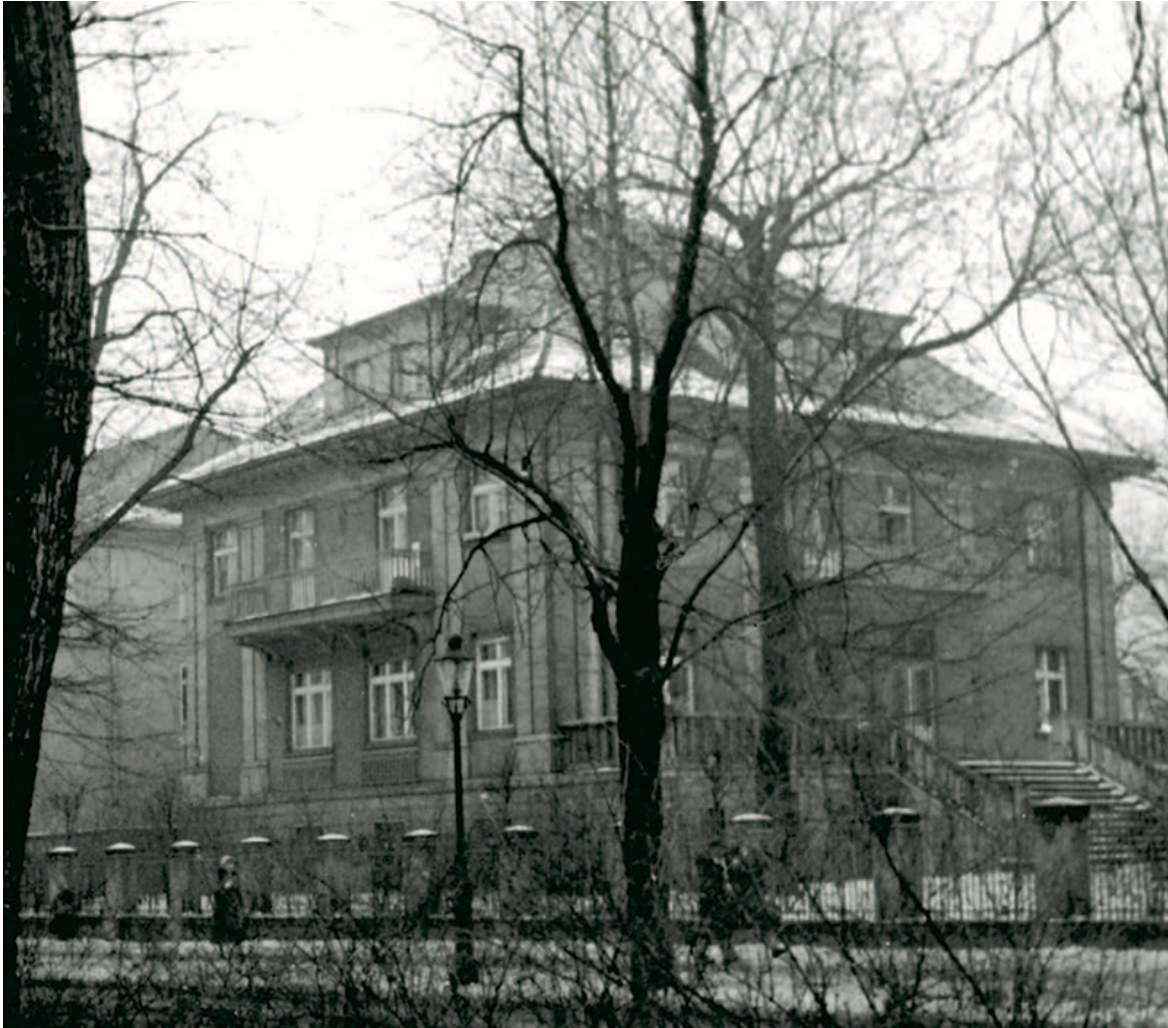
Konsulat USA w Poznaniu. Fotografia wykonana na potrzeby Departamentu II.
