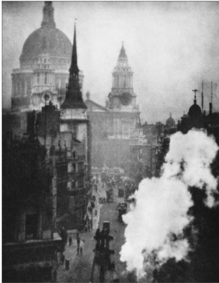
Londyn, 1910 rok. Katedra św. Pawła od strony Ludgate Circus , zdjęcie wykonane przez Alvina Langdona Coburna
