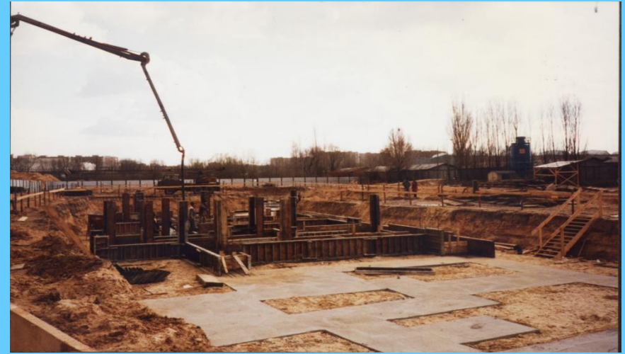
Betonowanie w szalunkach ław fundamentowych
