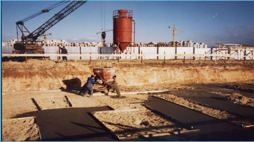
Układanie chudego betonu
