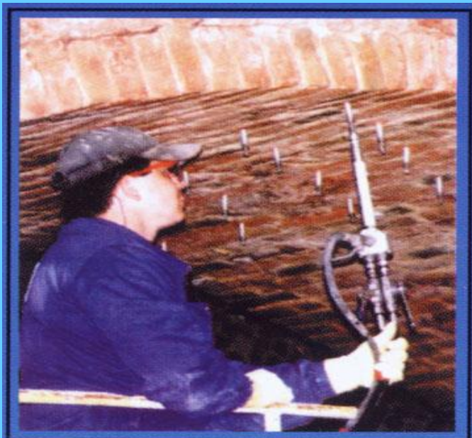
Schemat wykonania zabezpieczenia przeciwwilgociowego ścian zewnętrznych,
