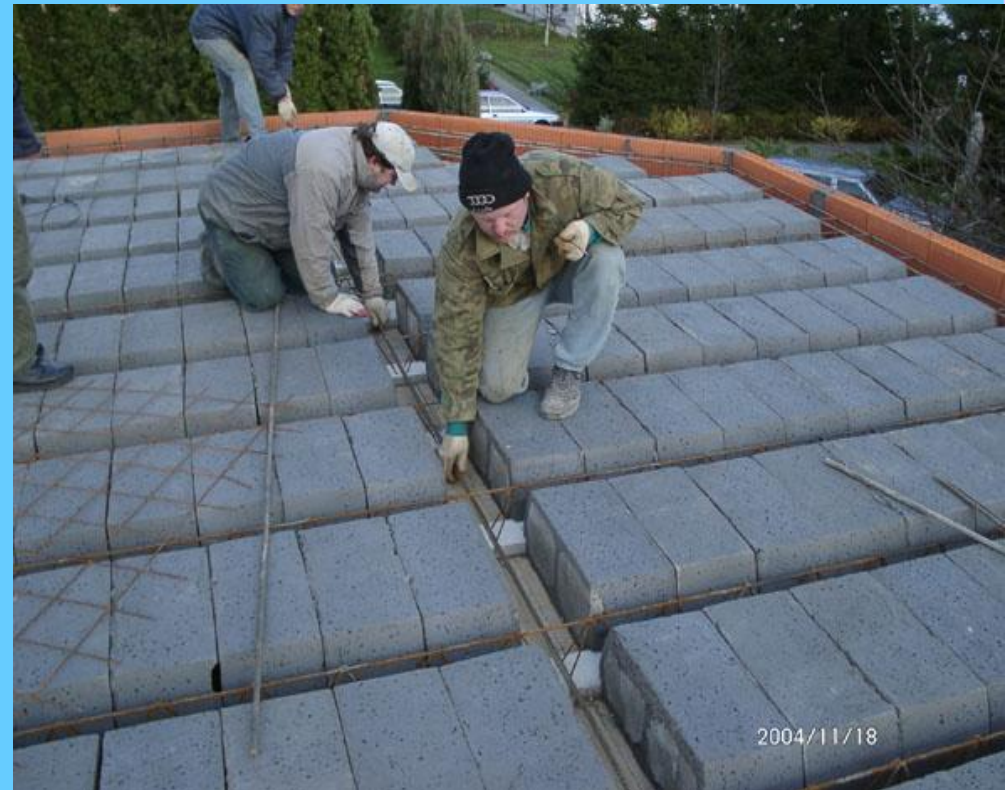
ZBROJENIE WIEŃCÓW, ŻEBRA ROZDZIELCZEGO, PODWÓJNA BELKA POD ŚCIANĄ DZIAŁOWĄ
