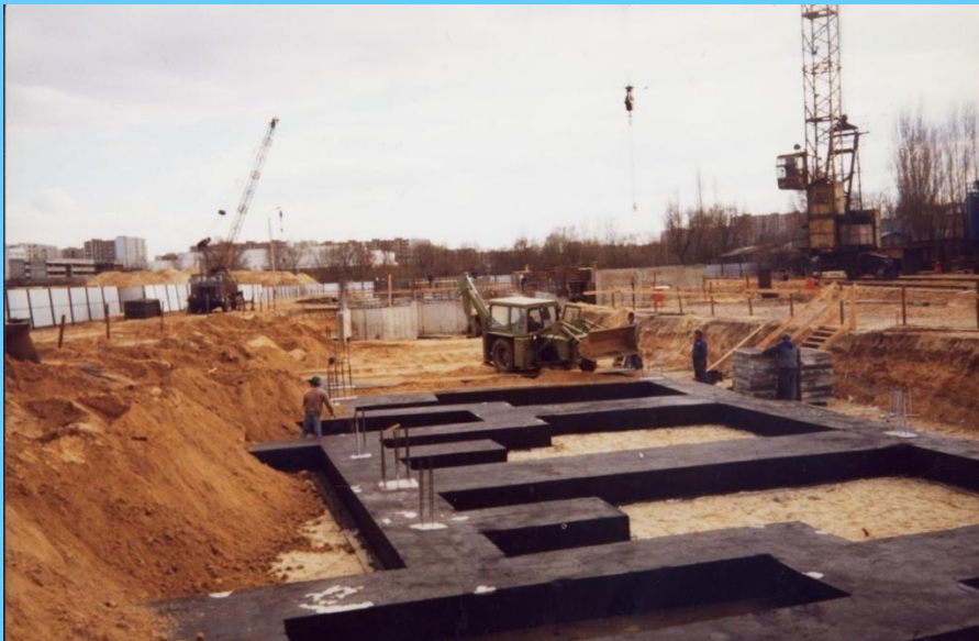
Układanie chudego betonu
