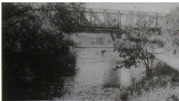
MARCISZÓW. MOST KOLEJOWY NA BOBRZE fot. M. Staffa
