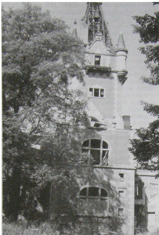
BOBRÓW. WIEŻA PAŁACU fot. M. Staffa
