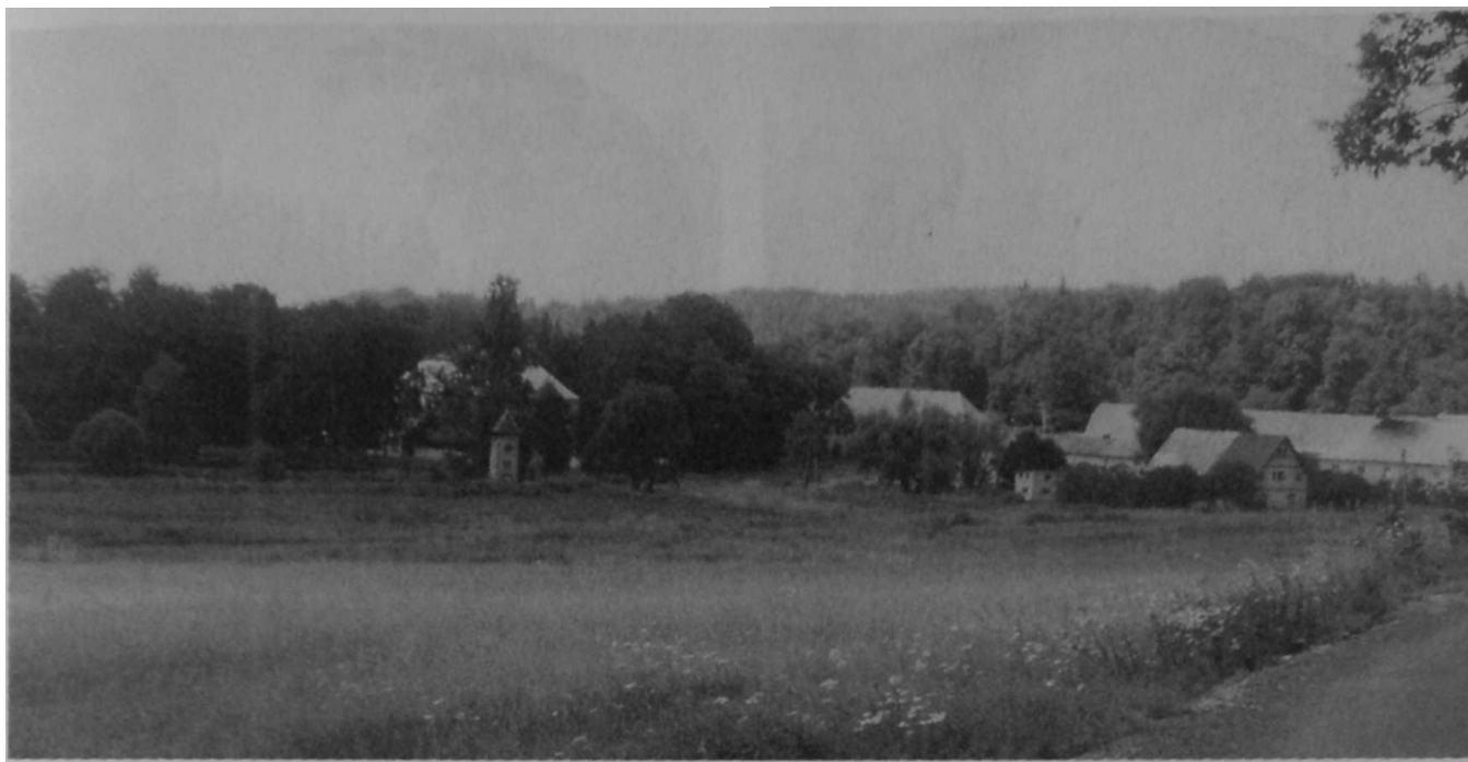
BUKOWIEC. WIDOK OGÓLNY fot. M. Staffa
