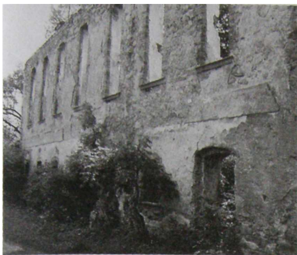
KARPNIKI. RUINA KOŚCIOŁA EWANGELICKIEGO fot. M. Staffa
