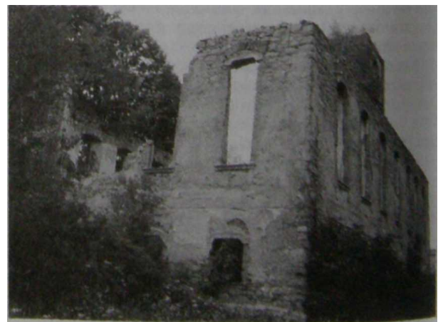
KARPNIKI. RUINA KOŚCIOŁA EWANGELICKIEGO fot. M. Staffa
