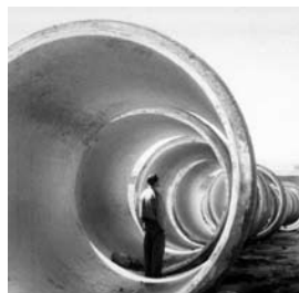
Przekrój betonowej rury wodociągu Krajowego (274 cm średnicy). FOT. DZIĘKI UPRZEJMOŚCI CENTRALNEGO ARCHIWUM SYJONISTYCZNEGO
