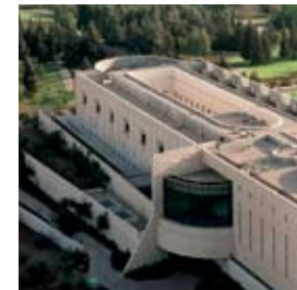
Budynek Sądu Najwyższego z lotu ptaka BIURO PRASOWE RZĄDU / A.OHAYON
