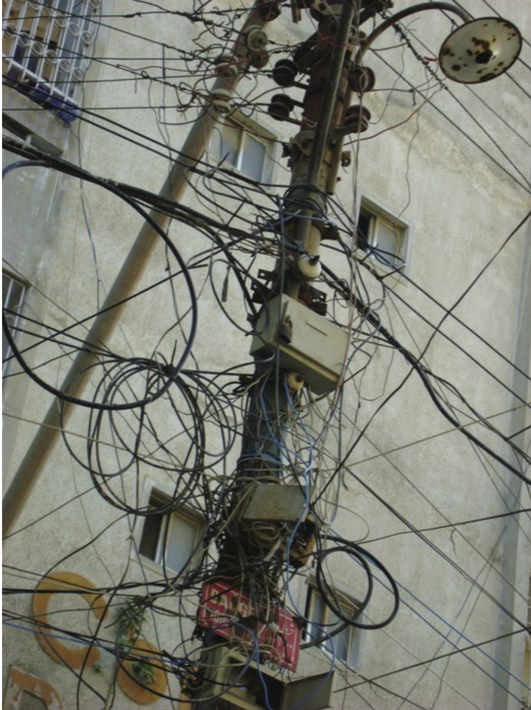
Kunda , czyli kable nielegalnie podłączone do legalnego źródła prądu. Jeden z kilku powodów, dla których w Karaczi tak często gaśnie światło.
