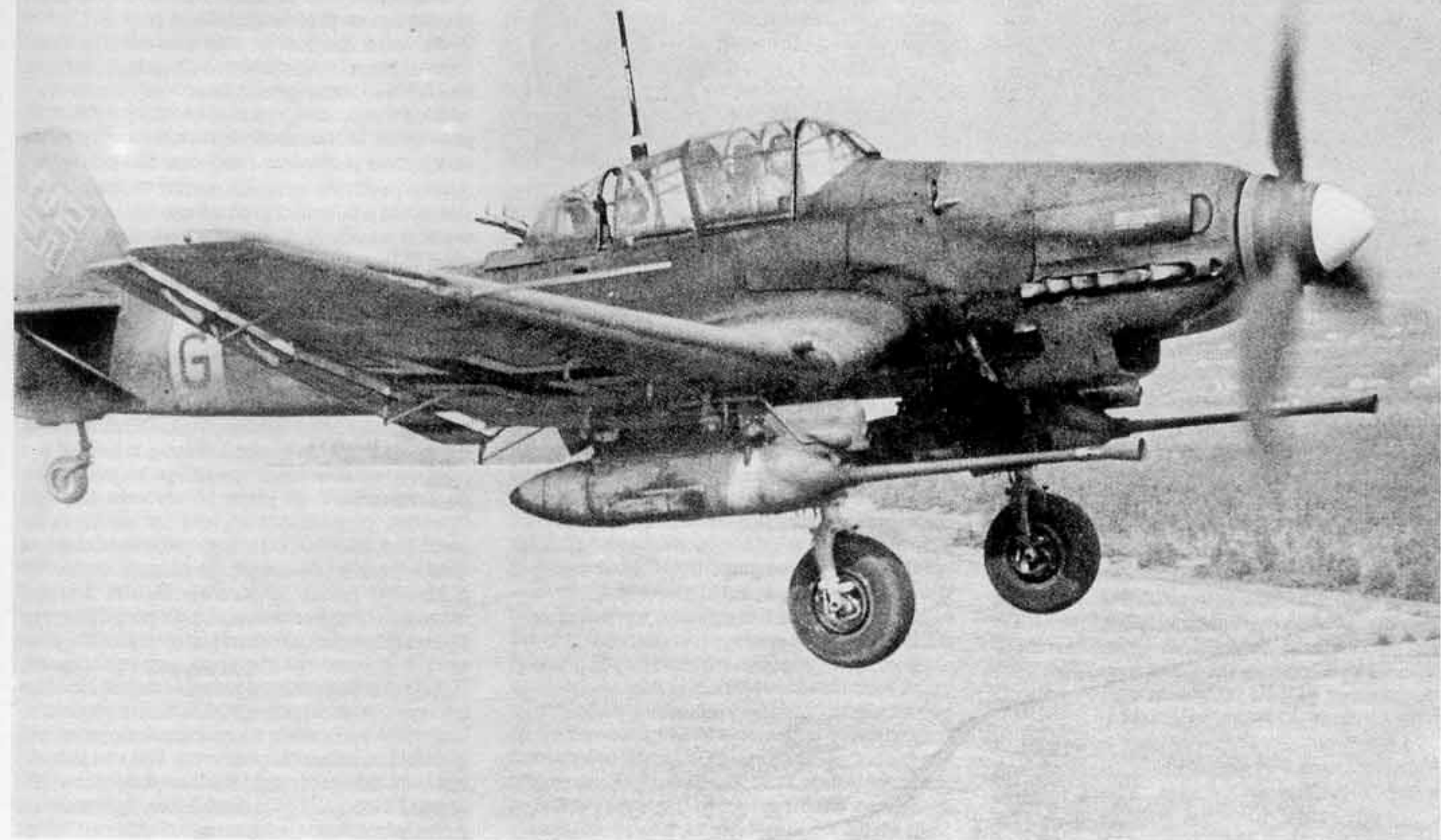
Ju 87 G-1 z podskrzyłowymi działkami BK 3,7 cm kalibru 37 mm w locie nad Frontem Wschodnim, 1943 rok.
