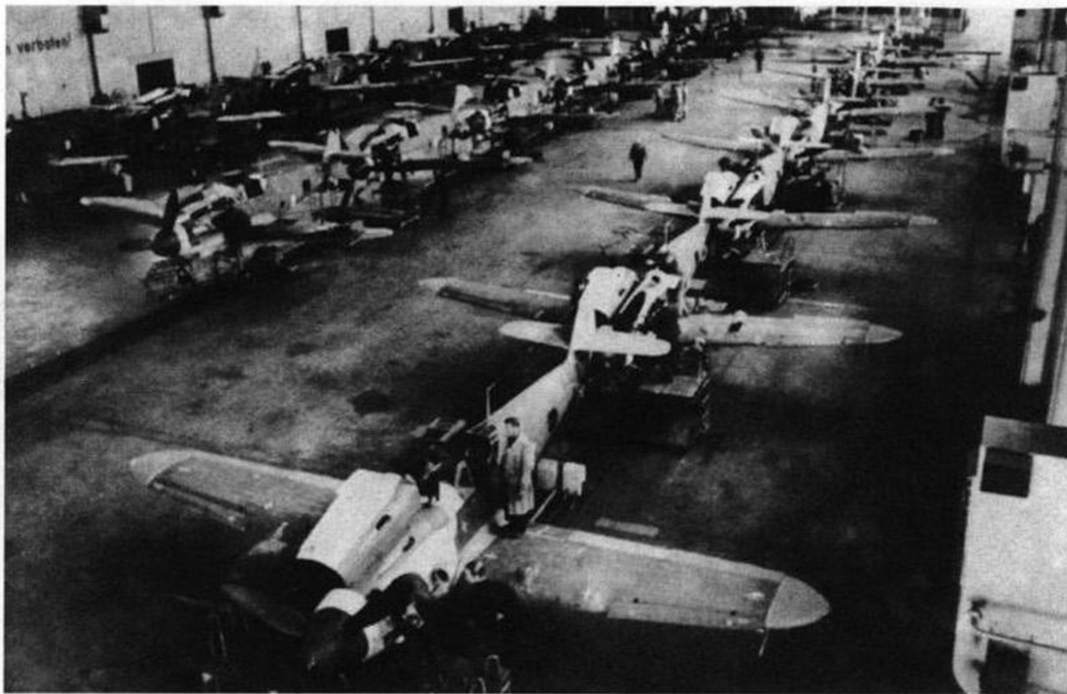
Wielkoseryjna produkcja Bf 109 G. Widoczne trzy równoległe linie ostatecznego montażu płatowców.
