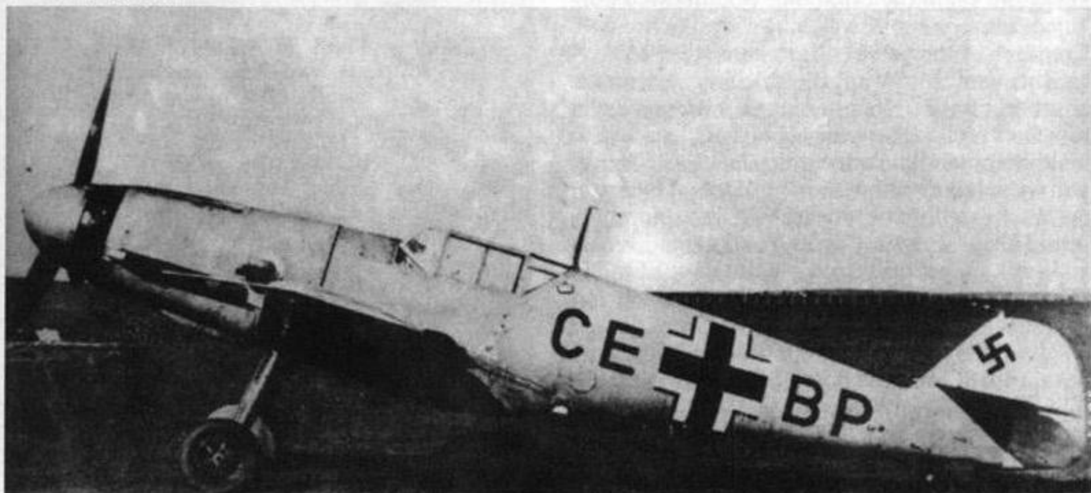
Jeden z przedseryjnych Bf 109 F - Bf 109 V23 (CE+BP). Widoczny nietypowy wlot powietrza do turbosprężarki.
