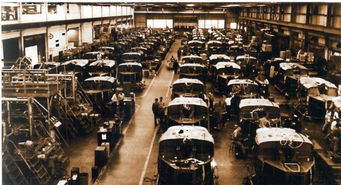
◀ Linia produkcyjna w fabryce Bella w Hurst w stanie Teksas. Widoczne na zdjęciu Hueye są w początkowej fazie budowy / Bell
