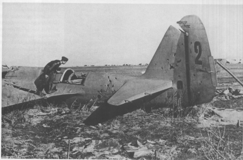
▲► SB-2 tzw. bis zmuszony do lądowania przez Niemców latem 1941 roku. Samolot nosi stary typ kamuflażu, który przestał być наносzony w połowie 1940 roku. Uwagę zwracają czerwone gwiazdy w czarnych obwódkach, namalowane na kołpakach. Na tylnych częściach łopatek śmigiel widać wyraźnie czarną farbę / CAN via R. Michulec
