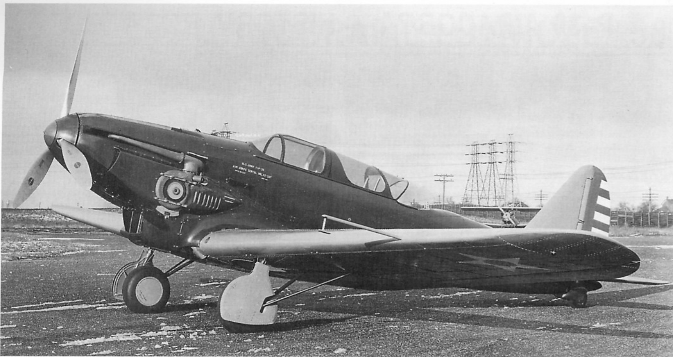
Consolidated Y1P-25 (s/n 32-321) konstrukcji Roberta Woods'a napędzany był silnikiem Curtiss V-1510-27, wyposażonym w turbosprężarkę. Bell, pracujący w tej firmie jako general manager, odniósł sukces finansowy, zwiększając zainteresowanie USAAC tym samolotem, owocujące dziesięciokrotnym wzrostem zamówień.
