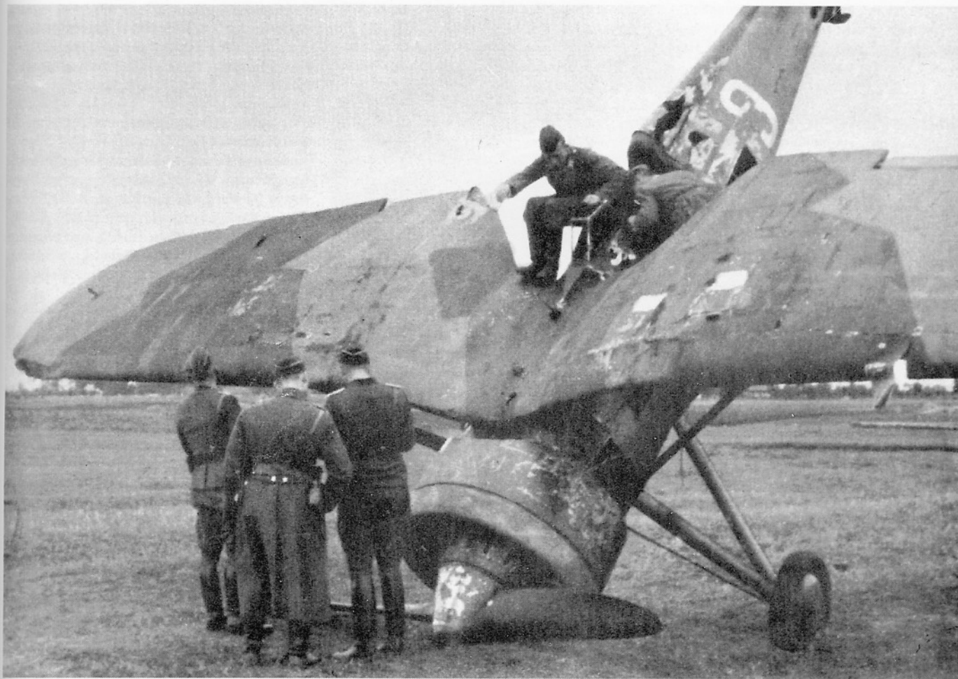
Samolot P.11c nr 3 (62-W) po kapotażu, zdobyty przez Niemców na Okęciu. Samolot ma nietypowy łącący kamuflaż badany w 1939 r. i nietypową literę W. Osłona silnika od P.11a - z wycięciem na górze
