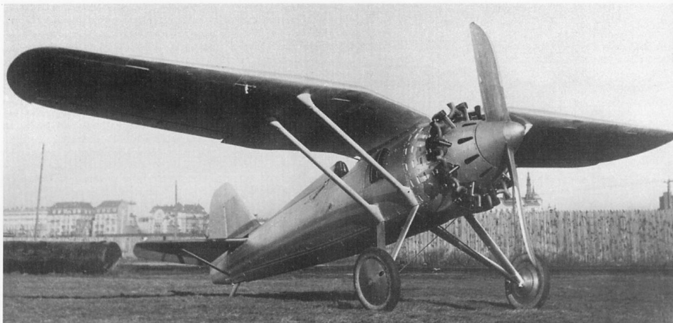
Dwa zdjęcia prototypu P.11/II-3 z długą owiewką za kabiną, bez uzbrojenia, z widocznym wiatrochronem. Samolot ma drewniane śmigło Chauvière o niemal stałej szerokości. Pasy na kadłubie i usterzeniu to cienie od zastrzałów i płata. Zdjęcia wykonano przed zachodem słońca na lotnisku mokotowskim (JEC)
