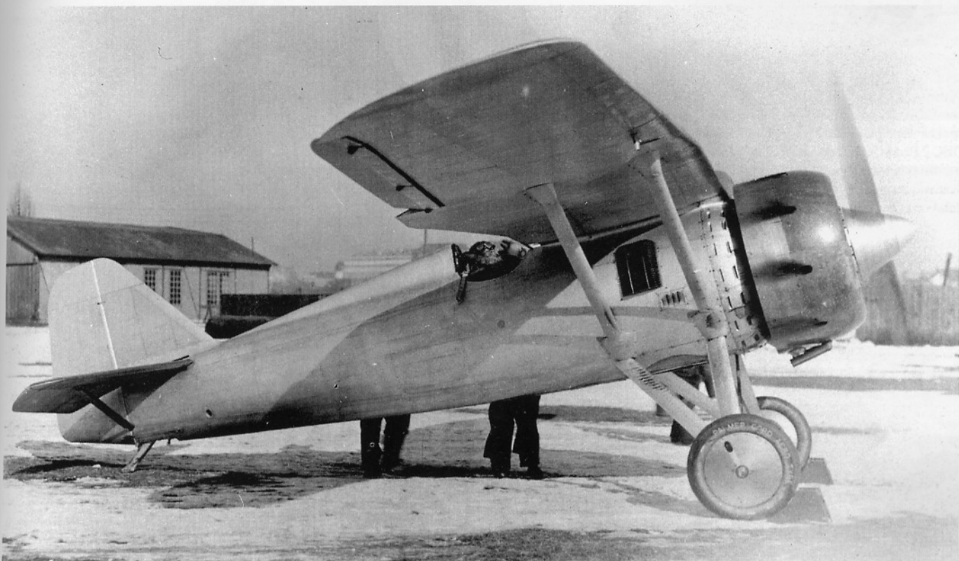
P.11/II-4 (w czwartej wersji, z długą owiewką za kabiną i drewnianym śmigłem. Samolot nie malowany. Osłona silnika jak w wersji P.11/II-2. Lotnisko mokotowskie zimą 1931/1932 (JEC)
