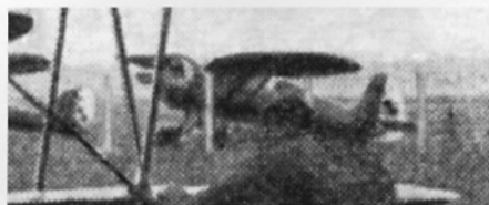
Produkcja P.11c w wytwórni PZL na Okęciu. W trakcie produkcji samolot przetaczano na drewnianych kołach
