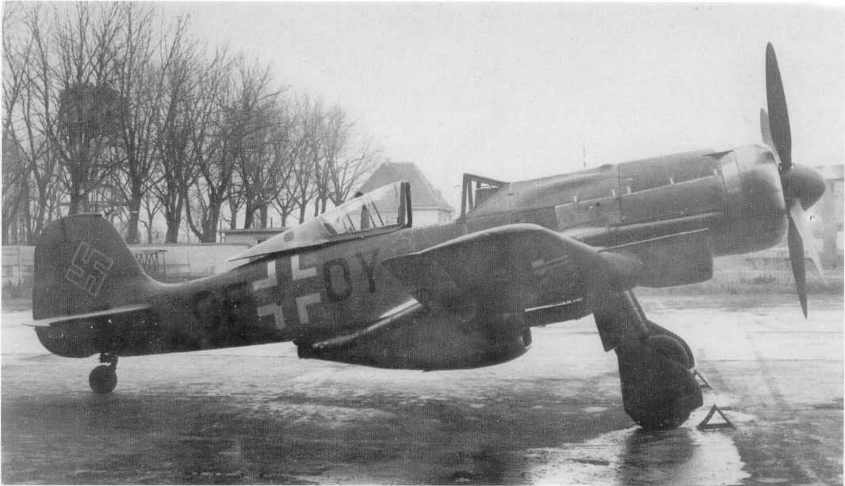
Fw 190 V18/U1. W przeciwieństwie do poprzedniej serii zdjęć te dwie fotografie prezentują samolot już w innym okresie prób, po dokonaniu jednej z kolejnych modyfikacji. Uwagę zwraca brak numeru seryjnego na stateczniku pionowym. (FW Neg.Nr.17969)
