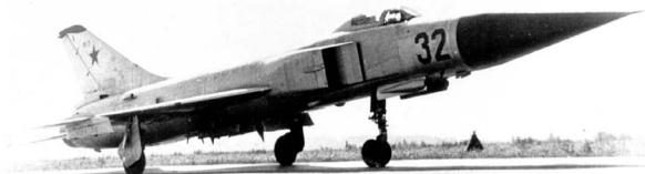
Prototyp T-58D-2 po wydłużeniu goleni przedniego podwozia. (Archiwum)
