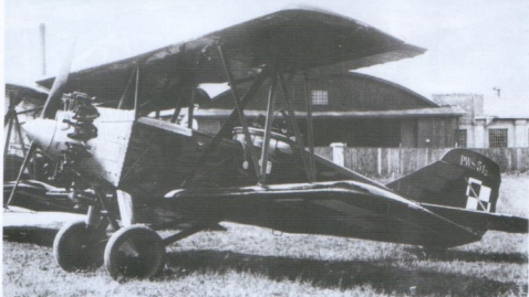
Poniżej: Zaprojektowany przez mjr inż. Wacława Makowskiego samolot sportowy PWS-50 wziął udział w zawodach Challenge 1930, których nie ukończył z powodu uszkodzenia podwozia w wyniku awarii silnika. (arch. W. Sankowski)
