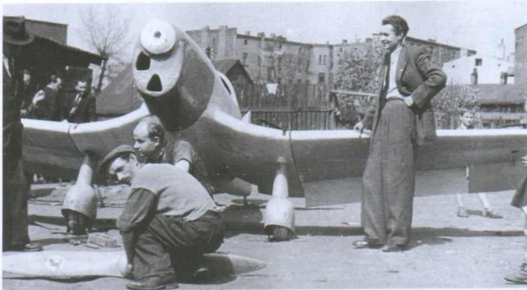
Powyżej: 3V11 w trakcie odbudowy, z prawej stoi Stanisław Meus. (arch. A. Morgała) Poniżej: Malowanie napisów, niespotykaną dzisiaj techniką, na odbudowanym 3V11 posiadającym już symboliczną rejestrację SP-OLL. (arch. A. Morgała)
