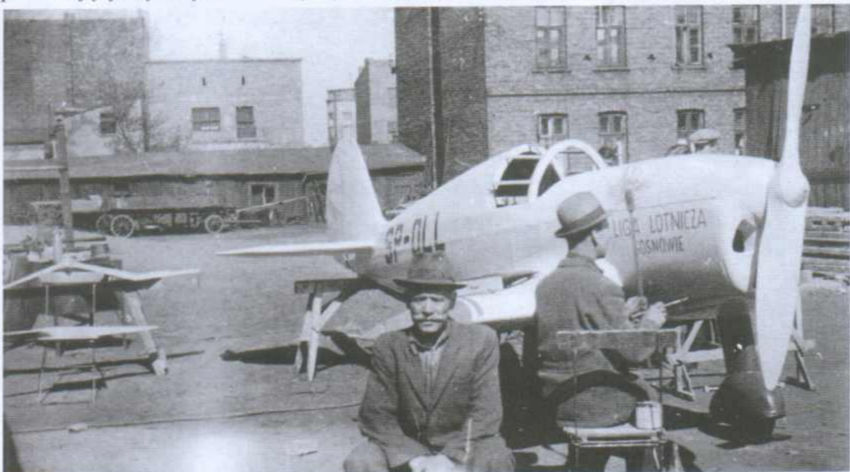
Powyżej: 3V11 w trakcie odbudowy, z prawej stoi Stanisław Meus. (arch. A. Morgała) Poniżej: Malowanie napisów, niespotykaną dzisiaj techniką, na odbudowanym 3V11 posiadającym już symboliczną rejestrację SP-OLL. (arch. A. Morgała)
