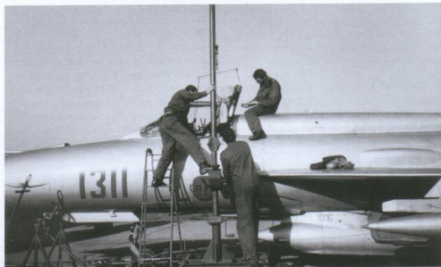
Powyżej: Wymiana fotela na samolocie „1311”. Sochaczew, lata osiemdziesiąte. (arch. A. Gołąbek)
