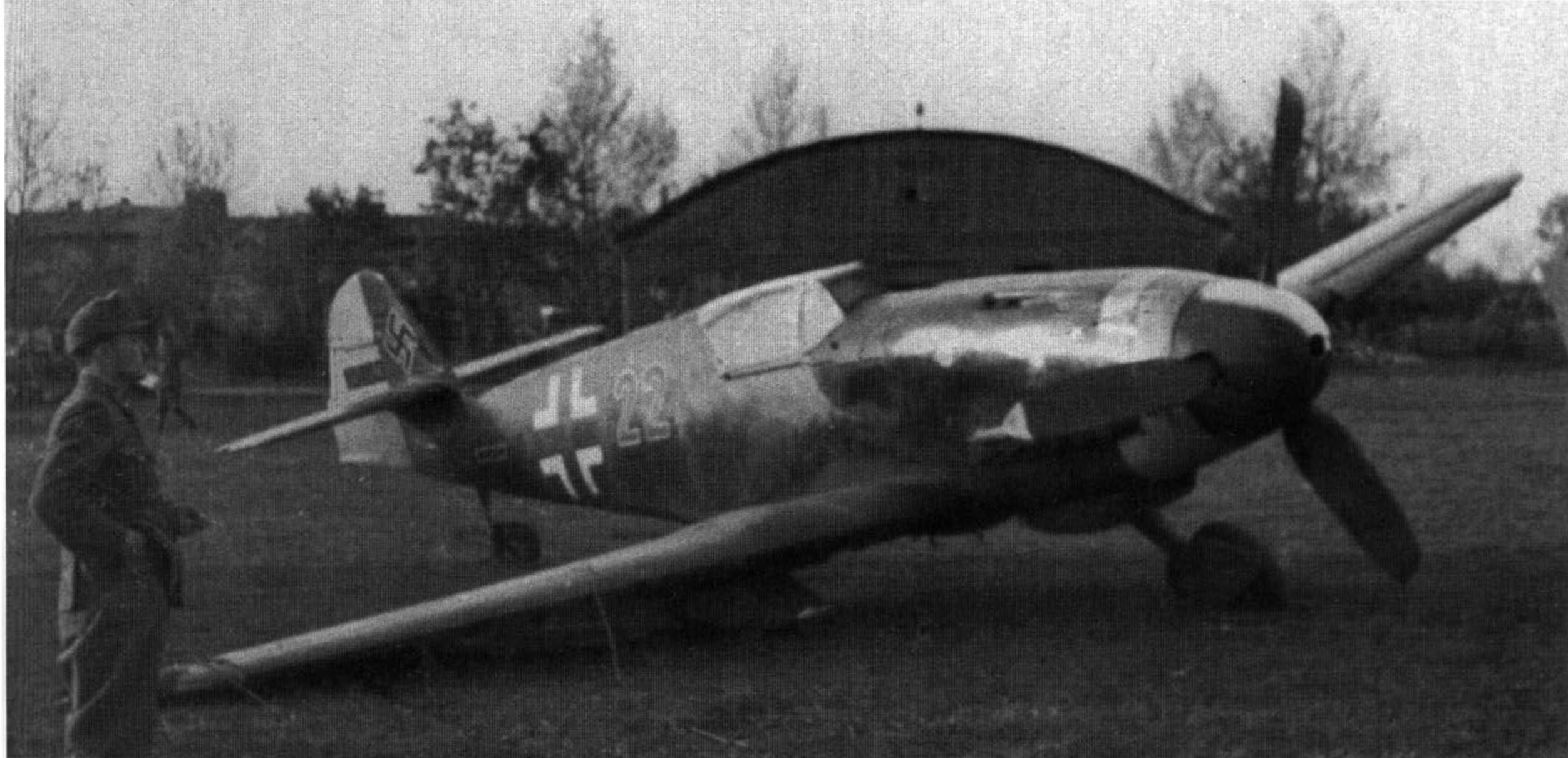
Me 109 G-10, W.Nr 15153? „czerwona 22-ka“ jednej z jednostek operujących na Froncie Wschodnim w 1945 roku (II/JG 52), co jest wyraźnie widoczne po żółtych elementach szybkiej identyfikacji na sterze kierunku i wokół silnika. Warto zwrócić uwagę na kamuflaż typu defensywnego, powstały w oparciu o barwy 81/82, lub 82/83.
