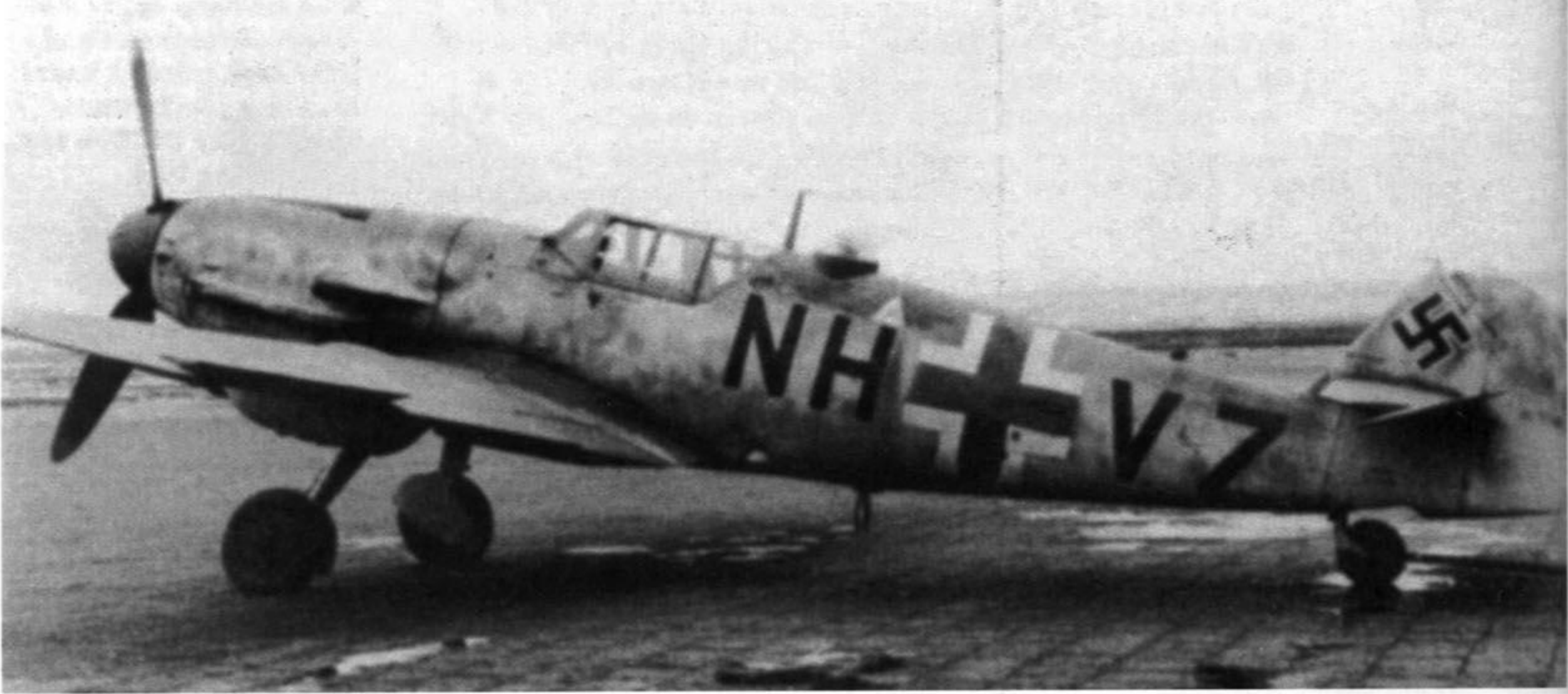
Me 109 G-6/R6 zmodyfikowany do pełnienia zadań nocnych poprzez zainstalowanie FuG 350 Naxos za kabiną pilota. Podobnie zmodyfikowanych maszyn istniało kilka, ale produkcji seryjnej takich „109” nie podjęto.
