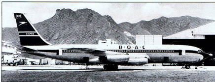
Pierwszą wersją z silnikami wentylatorowymi były samoloty serii 400, w których połączono uzbrojenie kadłub serii 300 z czterema silnikami Rolls-Royce Conway. Linie lotnicze BOAC były największym ich operatorem.
