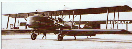
Palivo dla dwóch gwiazdowych silników Blériot 165 mieściło się w opływowych zbiornikach nad górnym skrzydłem. Ten egzemplarz nazwany został dla upamiętnienia kluczowej postaci we wczesnym okresie rozwoju maszyn latających.
