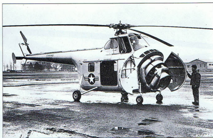
Jedną z charakterystycznych cech S-55 była łatwość dostępu do silnika Wright-Cyclone.
