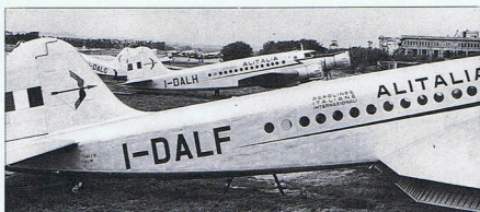
Na początku działalności Alitalia posiadała trójśmigłowe samoloty Fiat G.12L i G.12B (na zdjęciu). Przewoziły one od 16 do 22 pasażerów. G.12L był napędzany silnikiem Fiat A-74 RC.42 o mocy 566 kW (770 KM), a G.12B silnikiem Bristol Pegasus 48 o mocy 536 kW (730 KM).
