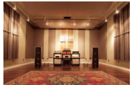
Sala odsłuchowa w Magico została zbudowana metodą „pokój-w-pokoju”. Pełna adaptacja akustyczna jest dziełem firmy RPG.
