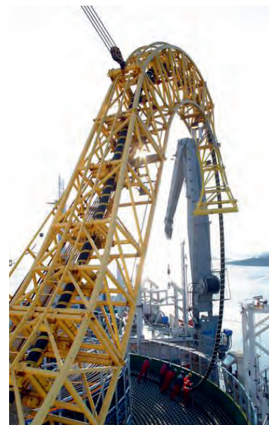
Fot. 25.7. Budowa linii wysokiego napięcia prądu stałego między Finlandią a Estonią. Para tych kabli przesyła moc rzędu 350 MW. Fot. ABB
