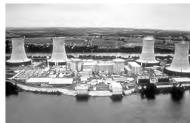
Fot. 24.4. Elektrownia jądrowa Three Mile Island
