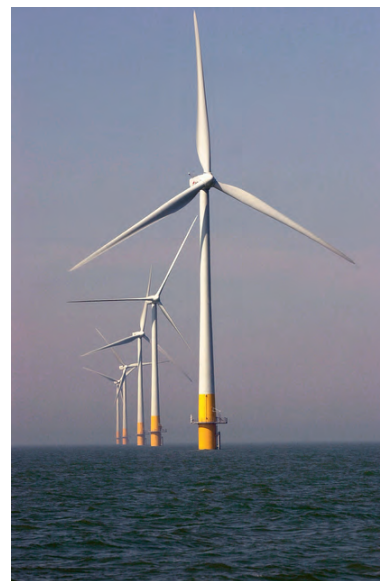
Fot. 10.1. Kentish Flats – farma wiatrowa w płytkich wodach przybrzeżnych. Każdy wirnik ma średnicę 90 m, a jego środek znajduje się w głowicy na wysokości 70 m. Każda turbina o mocy maksymalnej 3 MW waży 500 ton, połowa to waga fundamentów. Fot. © Elsam (elsam.com). Użyte za pozwoleniem
