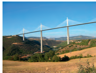
Fot. H.7. Millau Viaduct we Francji, najwyższy most świata. Konstrukcja stalowo-betonowa, dł. 2,5 km, wys. 353 m
