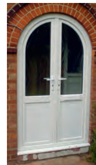
Fot. 21.6. Nowe drzwi frontowe
