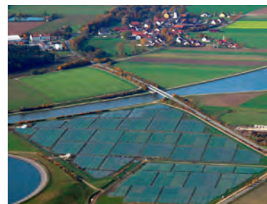
Fot. 6.7. Farma słoneczna z ogniwami fotowoltaicznymi: Park Słoneczny w Mühlhausen w Bawarii o mocy szczytowej wynoszącej 6,3 MW. Średnia moc na jednostkę powierzchni jest szacowana na około 5W/m 2 . Fot. SunPower
