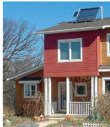
Fot. 30.2. Kolektor słoneczny podgrzewający wodę pewnej rodzinie z Michigan. Pompa kolektora jest zasilana niewielkim modulem fotowoltaicznym umieszczonym po lewej.
