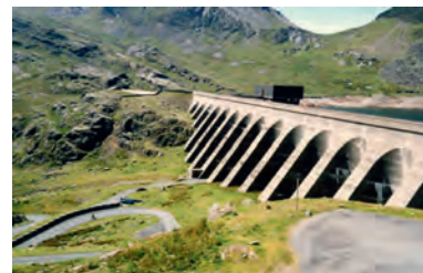
Fot. 26.6. Llyn Stwlan, górny zbiornik elektrowni szczytowo-pompowej Ffestiniog w północnej Walii. Magazynowana energia: 1,3 GWh. Fot. Adrian Pingstone
