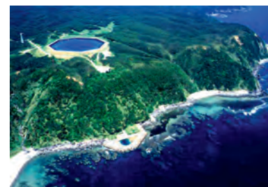
Fot. 26.11. Elektrownia szczytowo-pompowa na Okinawie. Tu ocean służy za dolny zbiornik. Magazynowana moc: 0,2 GWh. Zdjęcie publikujemy dzięki uprzejmości J-Power. www.ieahydro.org
