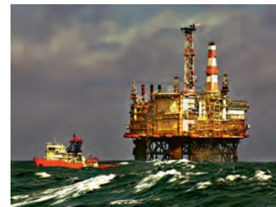
Fot. 10.4. Platforma Magnus, położona w brytyjskiej północnej części Morza Północnego, składa się z 71 000 ton stali.
