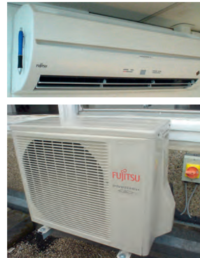
Fot. 21.11. Zewnętrzne i wewnętrzne elementy powietrznej pompy ciepła o współczynniku wydajności 4. Dla porównania obok wewnętrznej części umieszczono długopis. Ta pompa ciepła Fujitsu może dostarczyć 3,6 \text{ kW} ciepła, przy zużyciu zaledwie 0,845 \text{ kW} prądu. Może też pracować w odwrotną stronę, dostarczając 2,6 \text{ kW} chłodu i zużywając 0,655 \text{ kW} prądu.
