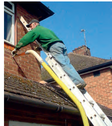
Fot. 21.5. Ocieplanie budynku
