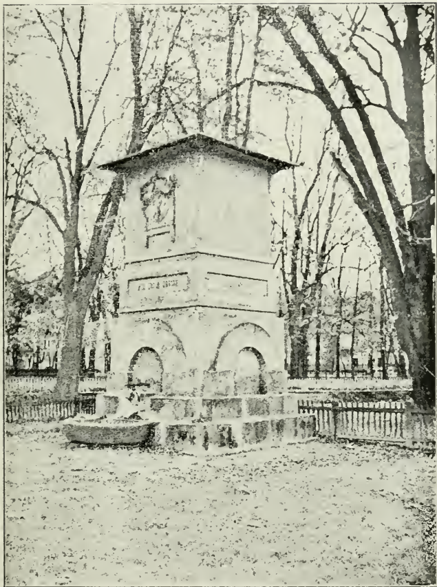
Siarczanka czyli główne źródło wody siarczanej w Krzeszowicach.
