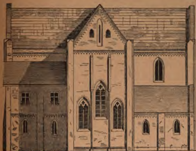
Fig. 9. Widok kościoła klasztornego (od wschodu).
