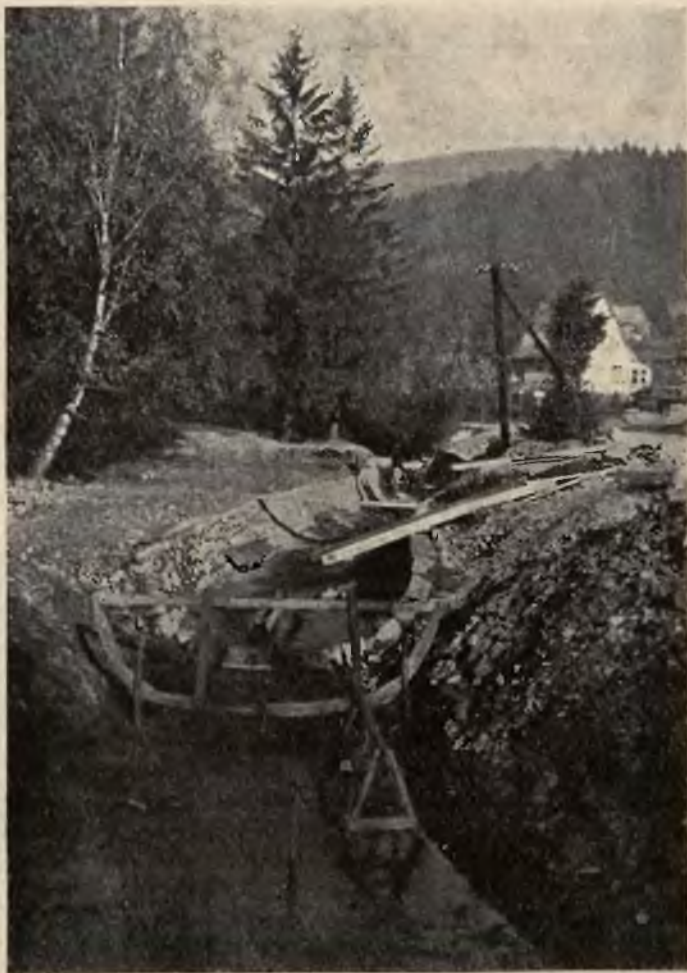
Budowa kamiennego żłobu na potoku Biła
