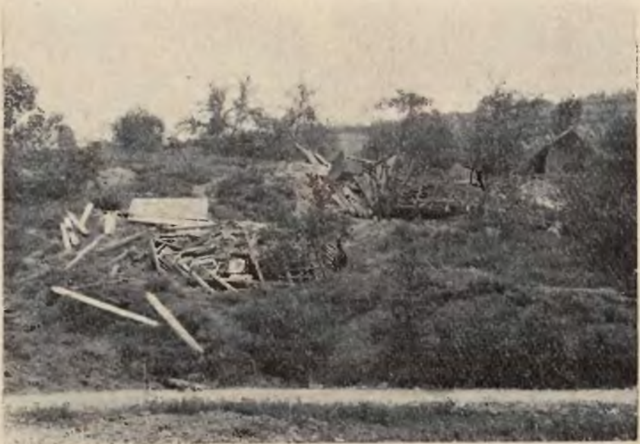
Osuwisko w Pcimiu. Zniszczone zabudowania
