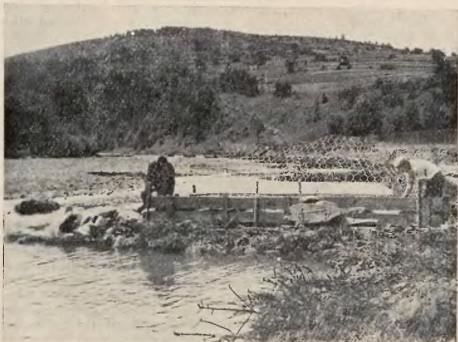
Ubezpieczenia faszynowe i siatkowo-kamienne na Ujsole
