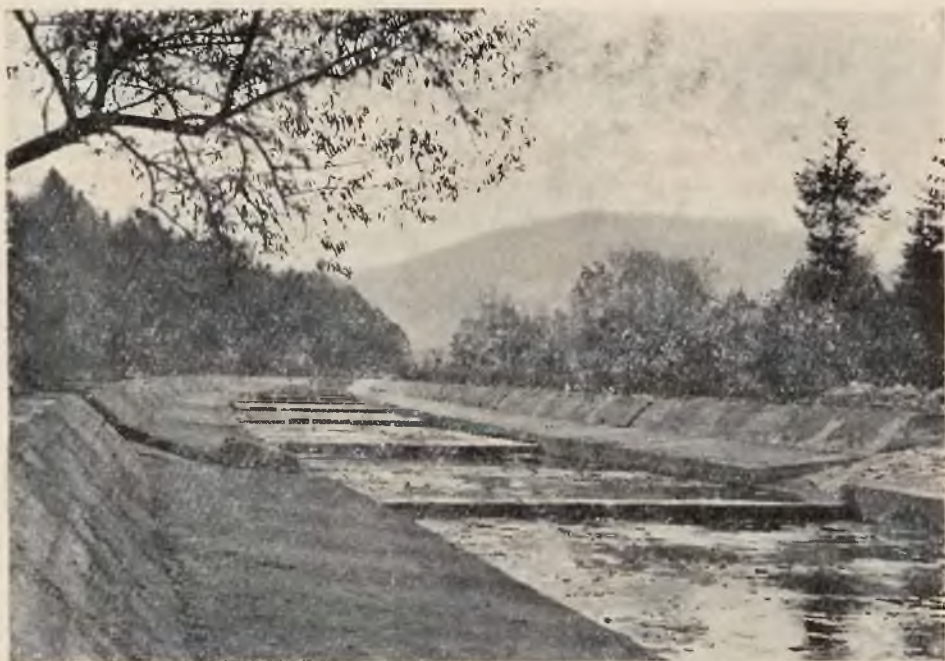
Uregulowany odcinek Żylicy. Koryto wybudowano w 1961 r.
