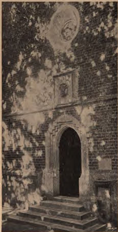
Fig. 4. Portal główny wejścia zachodniego do kościoła.
