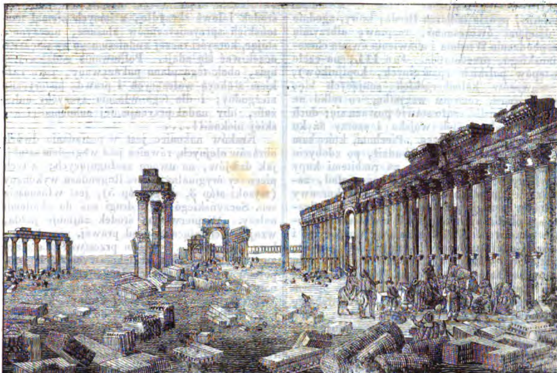
Szczątki wielkiej galerji w Palmirze.
