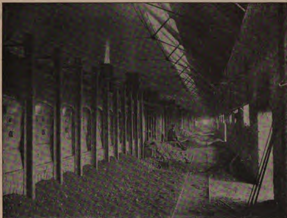
Wnętrze huty cynkowej w Dąbrowie Górniczej.
