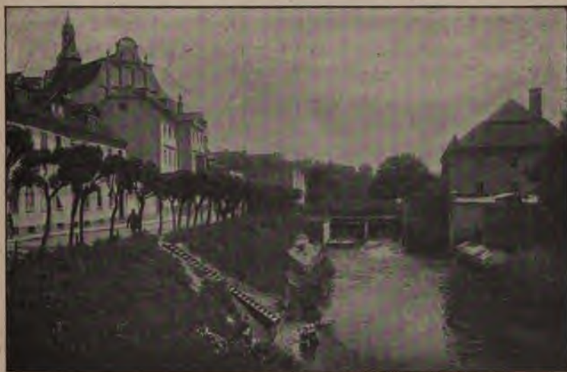
Kalisz. Widok z mostu kamiennego.
