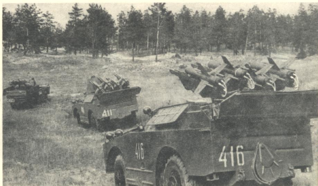
Pododdział radzieckich samobieżnych wyrzutni PPK na podwoziu BRDM podczas ćwiczeń. Zmieniony typ wyrzutni z czterema pociskami innej konstrukcji [Wyrzutnie 2P32 (pociski 9M17), z lewej: 2P27 (pociski 3M6) - przyp. PIBWL] fot. TASS
